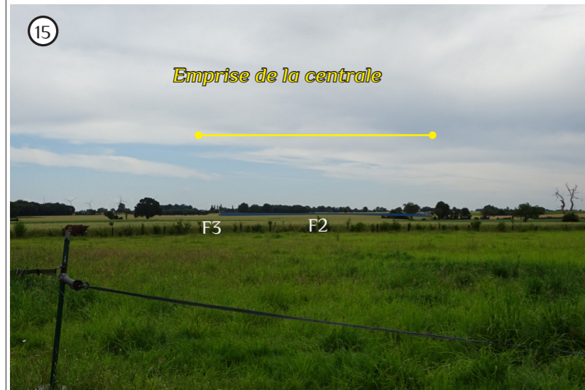
15 Emprise de la centrale Vision depuis le hameau de la Petite Saunière face aux berges F2 et F3. La surface en eau du bassin n'est pas visible. A l'extrémité de la pente F3, sont construits les 2 postes électriques
