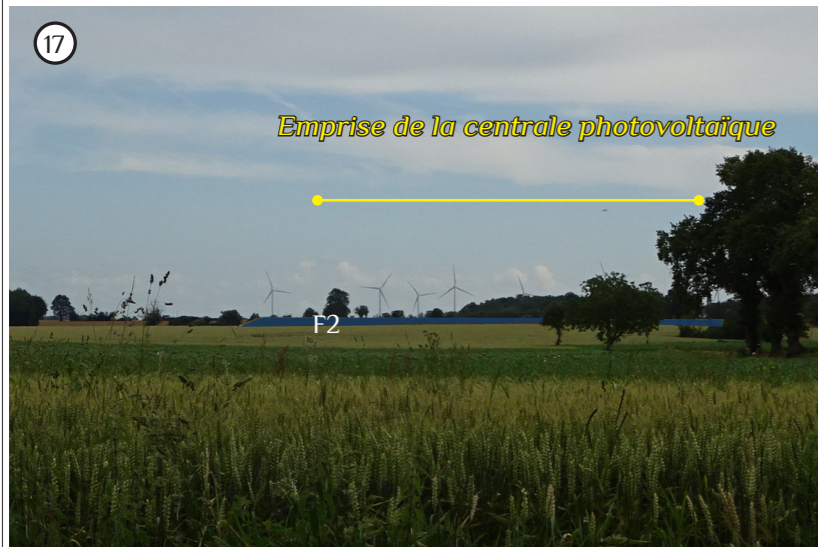
Fenêtre visuelle le long de la route entre la Petite Saunière et la Grande Saunière. Elle est orientée vers les faces F2 et F4 (dans une moindre mesure). Cette dernière (F4) est masquée par des écrans formés par la végétation. Le bassin apparaît en avant-plan d'un projet éolien
