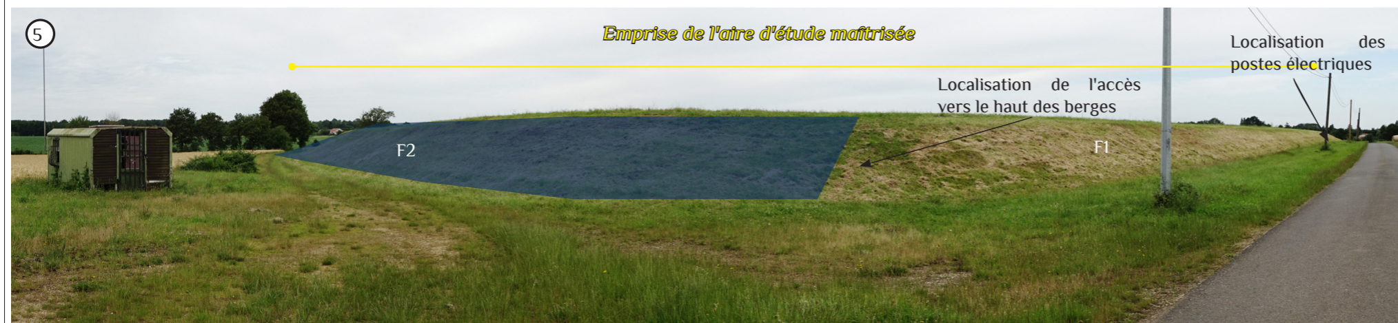
Vision depuis les abords immédiats du bassin au niveau de l'angle sud/sud-est. Ici, l'observateur fait face au portail principal qui assure l'accès à la centrale par ailleurs cernée d'une clôture de 2m. Un chemin d'accès en partie haute des berges est créé ici. Les panneaux photovoltaïques flottants ne seront pas visibles. Les postes installés à l'opposé de l'observateur sont à peine visibles masqués presque en totalité par les berges
