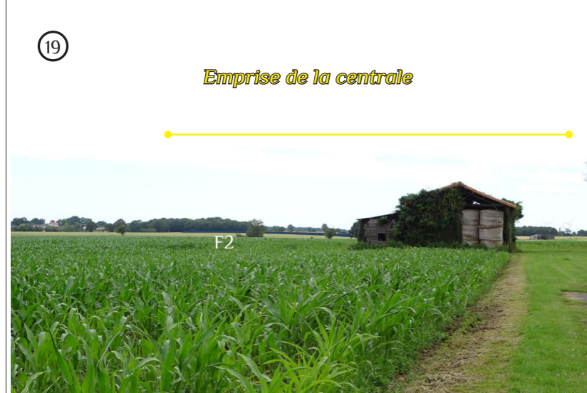
19 Emprise de la centrale Vision un peu plus éloignée et partielle du bassin depuis le hameau la Grande Saunière face à l'angle formé par les faces F2 et F4. Ce dernier est cependant masqué par un bâtiment agricole en avant-plan. Les pentes du bassin sont visibles partiellement mais la surface en eau est masquée
