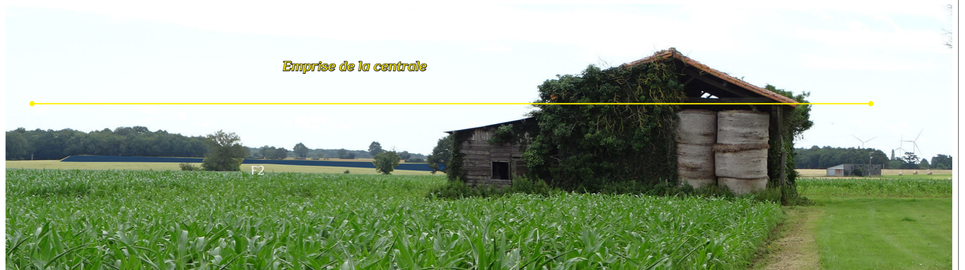
Photo 19 : zoom La berge F2, sur laquelle des lignes de panneaux photovoltaïques sont construites, est visible franchement et partiellement. En revanche la face F4 est entièrement masquée par un bâtiment agricole en avant-plan. Parmi les équipements visibles, on compte également la clôture. Les postes, quant à eux, sont masqués par les talus. Des éoliennes sont visibles en arrière-plan. Au vu de l'éloignement, de la richesse des motifs paysagers et de la vision partielle à nulle des composantes de la centrale, la prégnance de cette dernière dans le panorama global est faible
